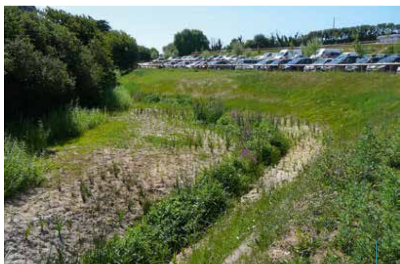
Les noues végétalisées combinent des fonctions hydrauliques (infiltration des eaux pluviales), économiques (coût moindre par rapport aux drains) et écosystémiques (nature en ville, biodiversité).
