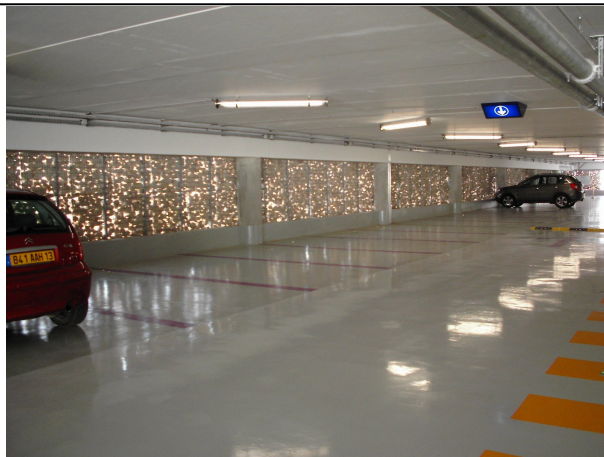
Vue générale intérieure
