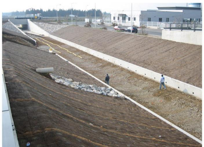
Le fond du cadereau est bétonné. L'enherbement a particulièrement bien fonctionné malgré la date tardive. Les taches blanches ou jaunes sur la couverture NAG C350 indiquent l'emplacement des fixations et permettent un gain de temps important et apportent plus de sécurité à la pose.
