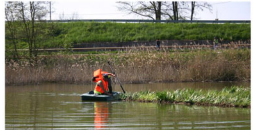
Une petite barque pour déplacer le radeau végétalisé et poser les lests aux angles.
