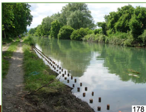
178 à 181. Un fascinage réalisé en place à l'aide de géofilet coco doublé d'un feutre et rempli de terre n'a pas résisté aux vagues dues au passage des bateaux. Le remplacement par des fascines préfabriquées et pré-végétalisées est beaucoup plus économique et en outre très efficace et durable.
