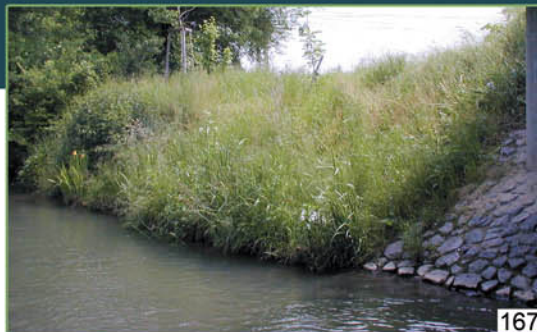
166 et 167. A l'aval du pont, superposition de deux niveaux de boudins coco. Le rang de dessus est pré-végétalisé. - 169 à 171 : Suède, Göteborg, Galtero : Réalisations en 2002.
