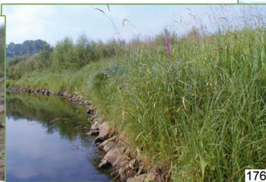
175 à 177. L'érosion importante dans cette courbe est stoppée par des blocs d'enrochements dont le haut est végétalisé à l'aide de géonattes pré-plantées. Un an plus tard, les enrochements ne sont plus visibles.
