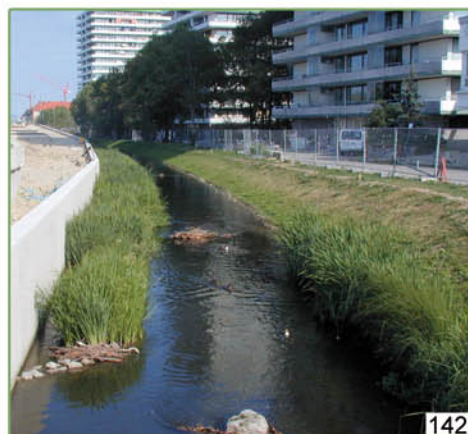
141 à 143. Munich : Végétalisation et protection de berges avec des géonattes pré-végétalisées.
