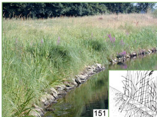
150 à 153. Végétalisation du haut de la protection en enrochements. - 154 à 156. Hambourg : Gabions matelas pré-remplis et végétalisés avec mise en place à l'aide d'un palonnier. Dans d'autres situations, il est très facile de disposer des géonattes pré-végétalisées sous le couvercle du gabion matelas (ou de les fixer dessus).
