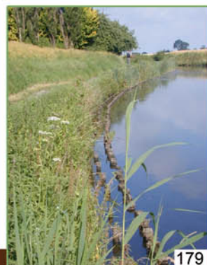
178 à 181. Un fascinage réalisé en place à l'aide de géofilet coco doublé d'un feutre et rempli de terre n'a pas résisté aux vagues dues au passage des bateaux. Le remplacement par des fascines préfabriquées et pré-végétalisées est beaucoup plus économique et en outre très efficace et durable.
