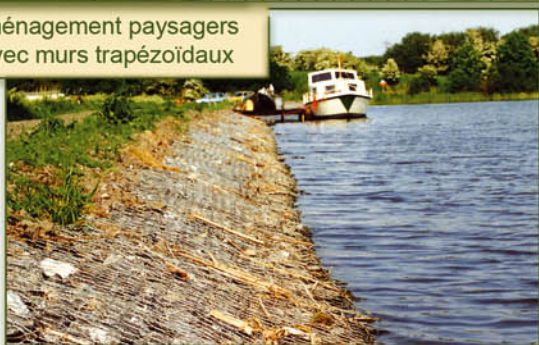
Protection de berge par matelas
