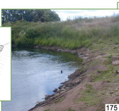
175 à 177. L'érosion importante dans cette courbe est stoppée par des blocs d'enrochements dont le haut est végétalisé à l'aide de géonattes pré-plantées. Un an plus tard, les enrochements ne sont plus visibles.
