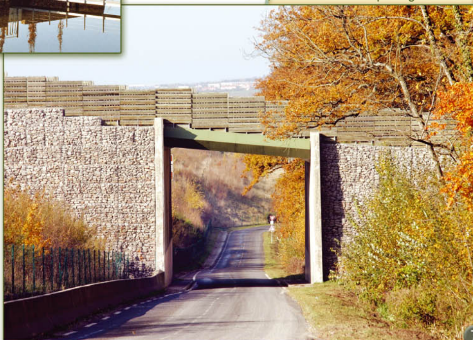
Soutènement d'un passage à faune
