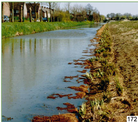
172 à 174. Installation de géonattes pré-végétalisées sur un canal navigable.
