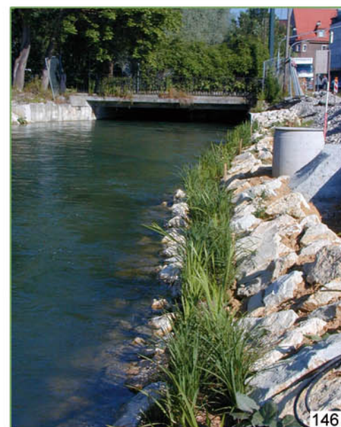
144 à 146. Insertion de nattes et fascines pré-végétalisées dans des protections d'enrochement.
