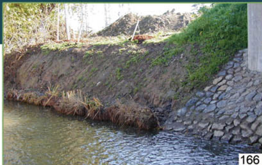
166 et 167. A l'aval du pont, superposition de deux niveaux de boudins coco. Le rang de dessus est pré-végétalisé. - 169 à 171 : Suède, Göteborg, Galtero : Réalisations en 2002.
