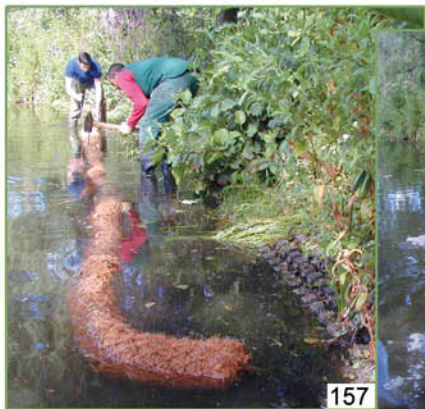
157 à 160. Végétalisation de dalles en béton alvéolé. Les boudins de coco nus sont tenus par des pieux bois ou des ancrages câbles plantés dans les alvéoles. L'espace arrière est remblayé et recouvert de géonattes pré-végétalisées.
