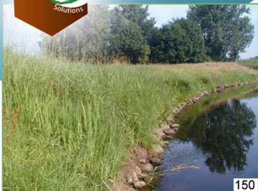
150 à 153. Végétalisation du haut de la protection en enrochements. - 154 à 156. Hambourg : Gabions matelas pré-remplis et végétalisés avec mise en place à l'aide d'un palonnier. Dans d'autres situations, il est très facile de disposer des géonattes pré-végétalisées sous le couvercle du gabion matelas (ou de les fixer dessus).
