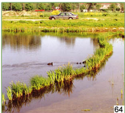
61 à 67. Pays Bas : Aménagement d'une zone humide. Modelage avec géonattes et fascines pré-végétalisées.
