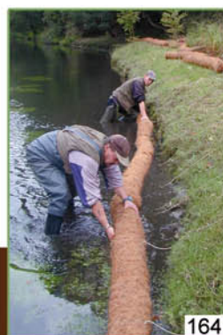
164 et 165. Pose d'un cordon de boudins de coco nus. Après fixation, l'espace entre la berge et la fascine est remblayé. Le boudin et la zone arrière sont ensuite recouverts de géonattes pré-végétalisées.
