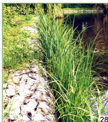
24. Chariot avec 1000 Phragmites en godets de 6x12 cm. - 25. Ces godets sont plus faciles à planter et ancrés plus profondément. - 26. Après installation des géonattes, rajouts de Typhas. - 27. Fascines d'hélophytes posées dans les enrochements. - 28. Fascines d'hélophytes fixées aux gabions. - 29. Végétation un an après la pose. - 30. Suède : Géonattes en pied de berge et géofilet coco au dessus.
