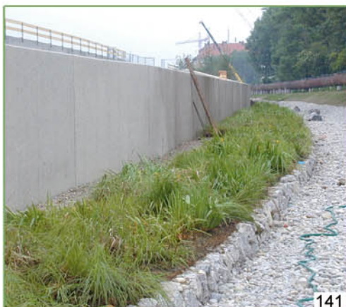
141 à 143. Munich : Végétalisation et protection de berges avec des géonattes pré-végétalisées.
