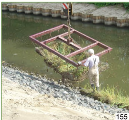
150 à 153. Végétalisation du haut de la protection en enrochements. - 154 à 156. Hambourg : Gabions matelas pré-remplis et végétalisés avec mise en place à l'aide d'un palonnier. Dans d'autres situations, il est très facile de disposer des géonattes pré-végétalisées sous le couvercle du gabion matelas (ou de les fixer dessus).
