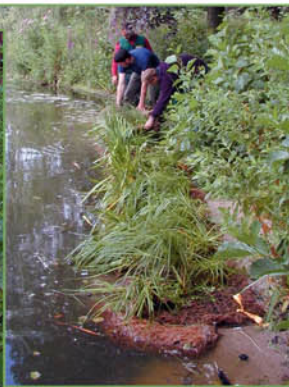
157 à 160. Végétalisation de dalles en béton alvéolé. Les boudins de coco nus sont tenus par des pieux bois ou des ancrages câbles plantés dans les alvéoles. L'espace arrière est remblayé et recouvert de géonattes pré-végétalisées.
