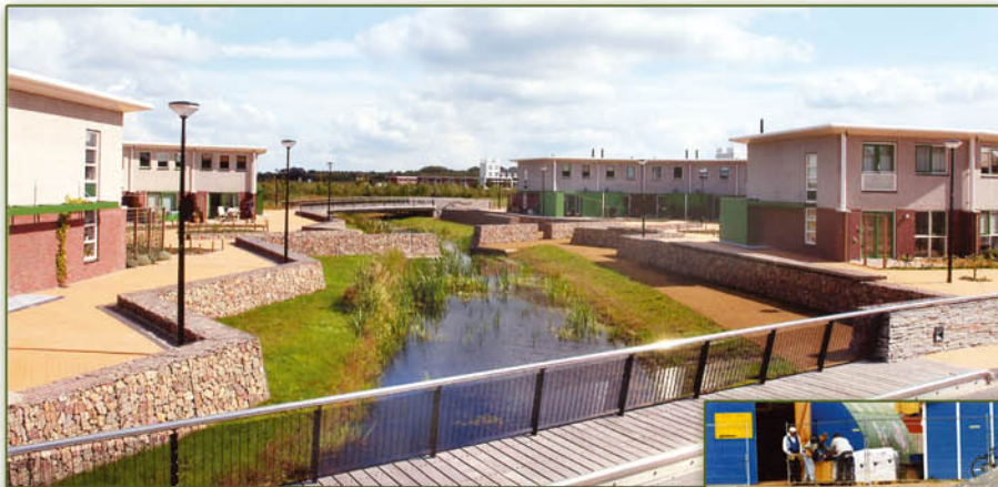
Aménagement paysagers avec murs trapézoïdaux
