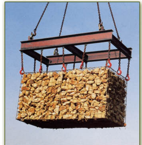
Préfabrication et manutention sans déformation
