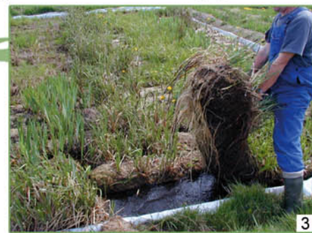
1, 2 et 3. Géonatte et fascine d'hélophytes pré-végétalisées avec un système racinaire bien développé et visible.
