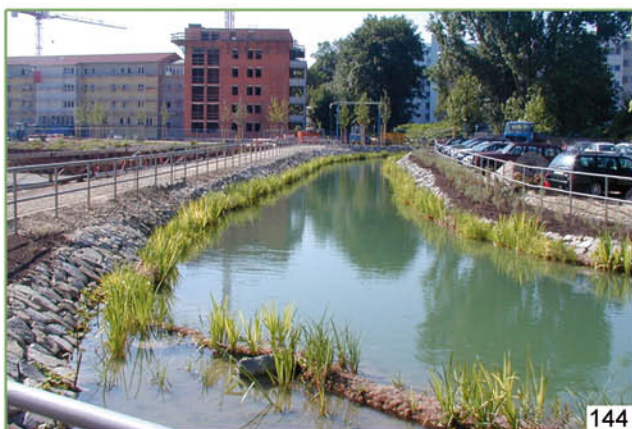
144 à 146. Insertion de nattes et fascines pré-végétalisées dans des protections d'enrochement.
