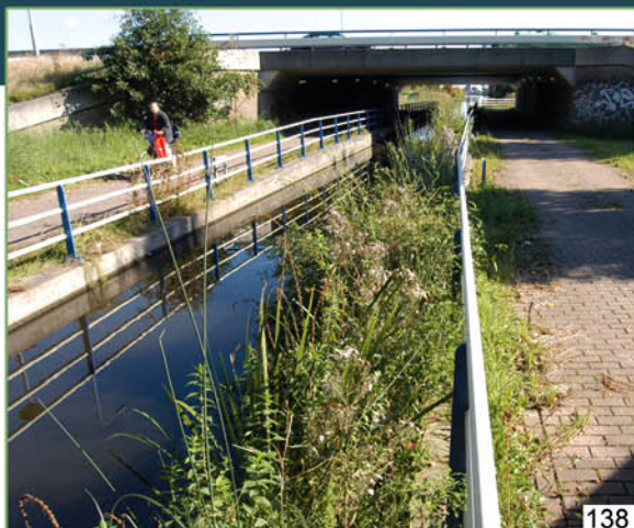
138 à 140. Végétalisation d'un canal par fascines d'hélophytes.
