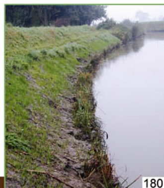
178 à 181. Un fascinage réalisé en place à l'aide de géofilet coco doublé d'un feutre et rempli de terre n'a pas résisté aux vagues dues au passage des bateaux. Le remplacement par des fascines préfabriquées et pré-végétalisées est beaucoup plus économique et en outre très efficace et durable.
