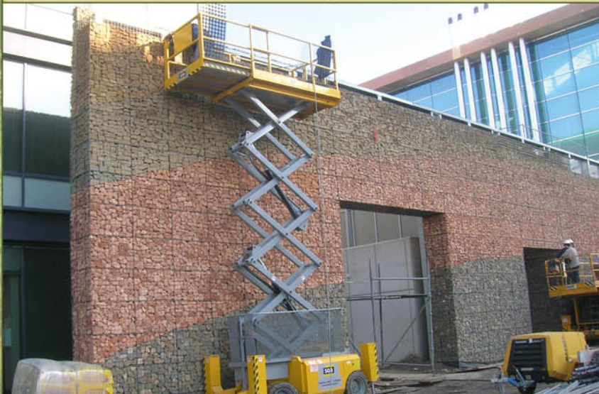
Réalisation d'une façade de 8.4 m avec vagues de pierres de couleurs différentes
