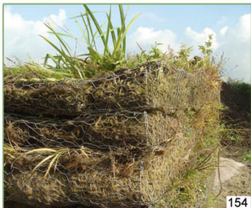
150 à 153. Végétalisation du haut de la protection en enrochements. - 154 à 156. Hambourg : Gabions matelas pré-remplis et végétalisés avec mise en place à l'aide d'un palonnier. Dans d'autres situations, il est très facile de disposer des géonattes pré-végétalisées sous le couvercle du gabion matelas (ou de les fixer dessus).
